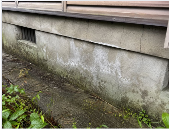
基礎部分 ひび割れ・欠損の有無
