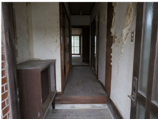
玄関・廊下 壁・床・残置物の状態
