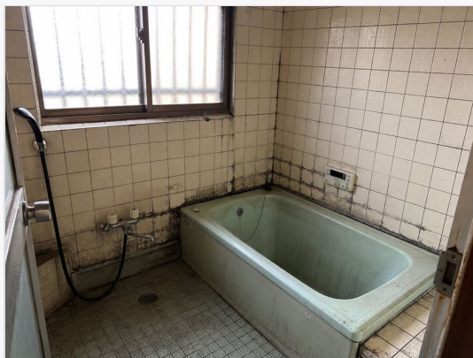
浴室 浴槽・タイル・カビの状態
