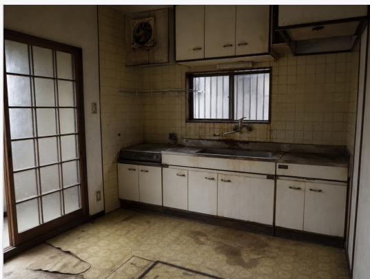
台所全体 設備・床・壁の状態
