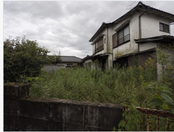
庭・外構 草木の繁茂・フェン ス・門扉の状態
