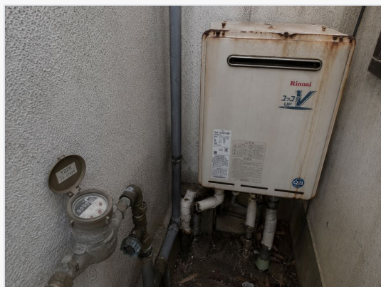
給湯器・水道 設備の状態・型番
