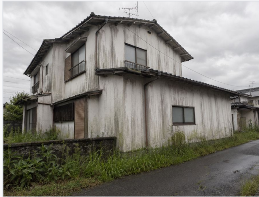
外観側面 屋根の状態・外壁の変色・雨樋の状態
